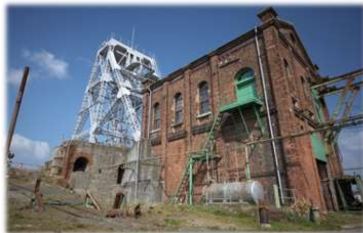
世界文化遺産に登録された宮原坑及び三池炭鉱専用鉄道敷跡（上）と万田坑（下）
