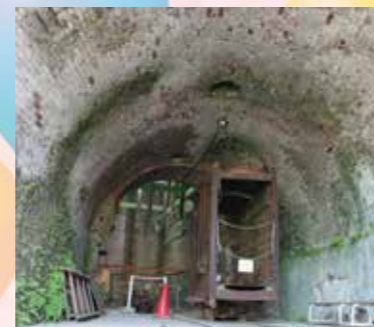
▲万田坑入坑口
