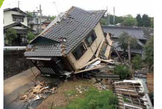
熊本地震 熊本県益城町 【出典: 熊本地震デジタルアーカイブ/ 提供者: 鳥取県東部広域行政管理局消防局】
