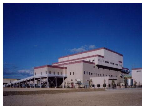
大牟田・荒尾RDFセンター
