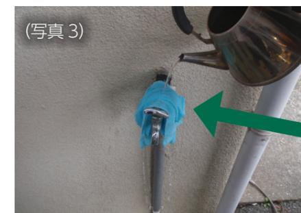
もしも、蛇口が凍結したときは、写真のようにタオルをあててから、ぬるま湯をかけてください。熱湯をかけると水道管などが破損する場合があります。
