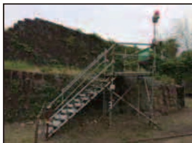
階段の設置(仮設による現状の整備)
