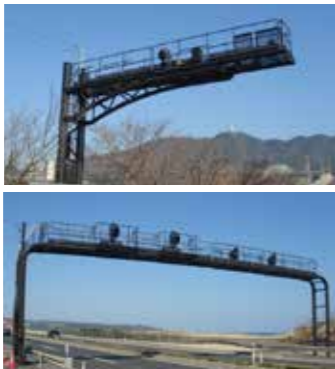
▶実際に設置されたF型とアーチ型の鋼管柱
