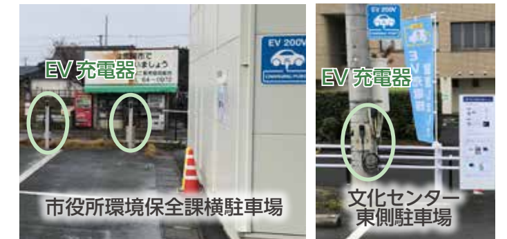
◎EV充電器の設置場所は、青い旗とマークが目印です。
