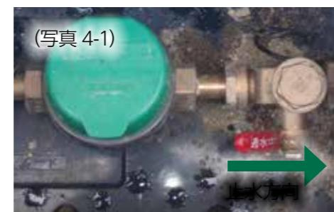
宅地内の配管で漏水が止まらないときは、水道メーターボックス内にある止水栓を回して止水してください。また、止水栓を年2回程度動かして作動状況の確認をお願いします。
