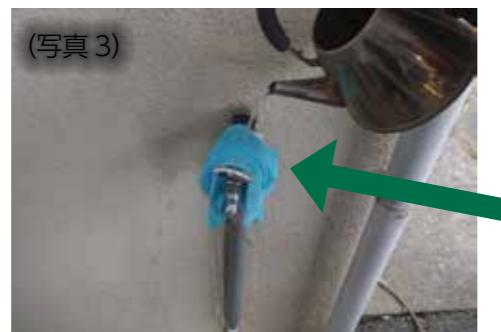
もしも、蛇口が凍結したときは、写真のようにタオルをあててから、ぬるま湯をかけてください。熱湯をかけると水道管などが破損する場合があります。
