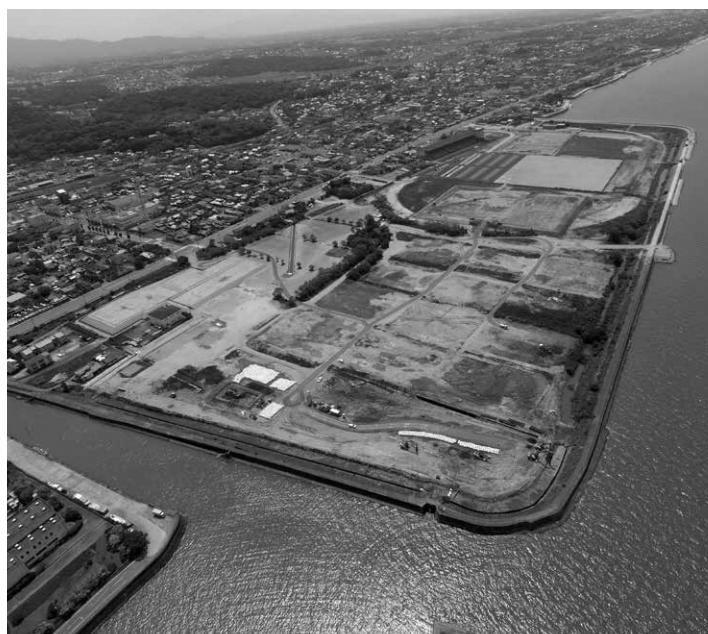
【土地区画整理事業が進められている南新地地区】
