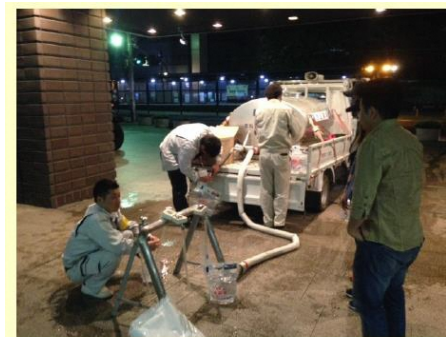
平成28年4月熊本地震による 官民共同による応急給水の様子
