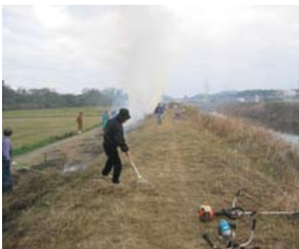
浦川堤防の除草・清掃
