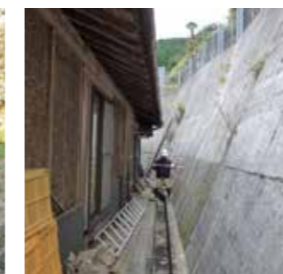
▲斜面構造物の設置状況や形状を確認します。
