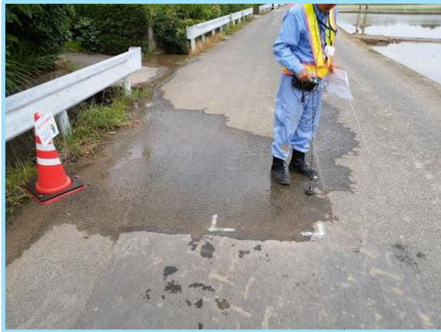
写真 3-9：専用の機器を使って漏水箇所を特定している風景
