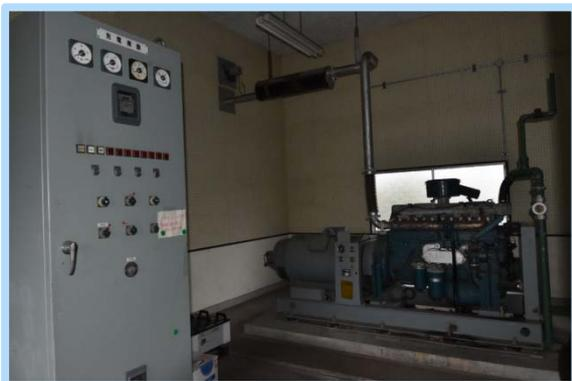
写真 3-6: 八幡台水源地の自家用発電機
