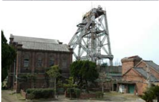
(左) 巻揚機室 (中央) 万田坑堅坑櫓 (右) 倉庫およびポンプ室
