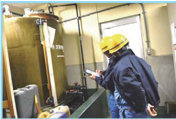
写真 3-8：水道施設の点検風景
