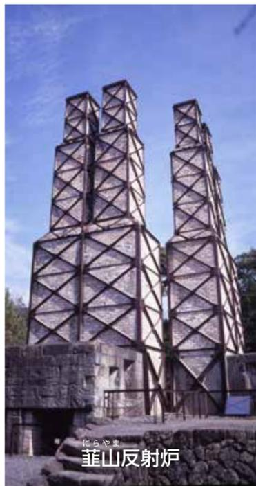
静岡県東部の伊豆の国市に位置する葦山は、中世の幕開けを告げる源頼朝の挙兵をはじめ、日本の歴史上の大きな変革の始まりとなった地です。幕末には日本の近代化の礎となった最先端の工場である葦山反射炉が築かれました。反射炉とはドーム状の天井に熱を反射させ不純物を多く含む鉄を溶解し、良好な鉄を生産するための製鉄炉です。
