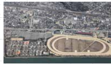
▲建設地：荒尾競馬場跡地（26haある敷地の一部に建設します。）
