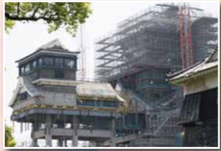
▲足場が組まれた熊本城。その姿はまるで要塞のようです
