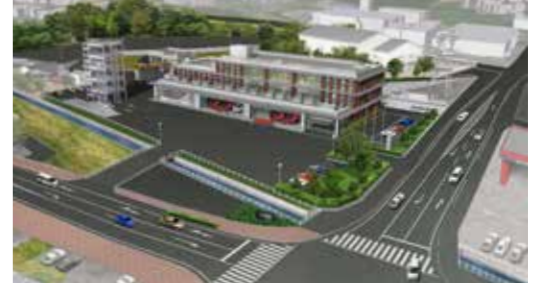
▲8,600㎡ほどの敷地に建設され、県内でも有数の規模となり、燃焼実験室などの最新設備も備えられます。
