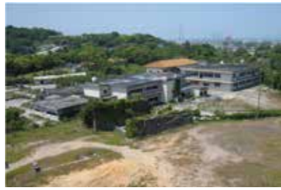
第一竖坑関連施設跡が地下に残るアソニット施設跡
