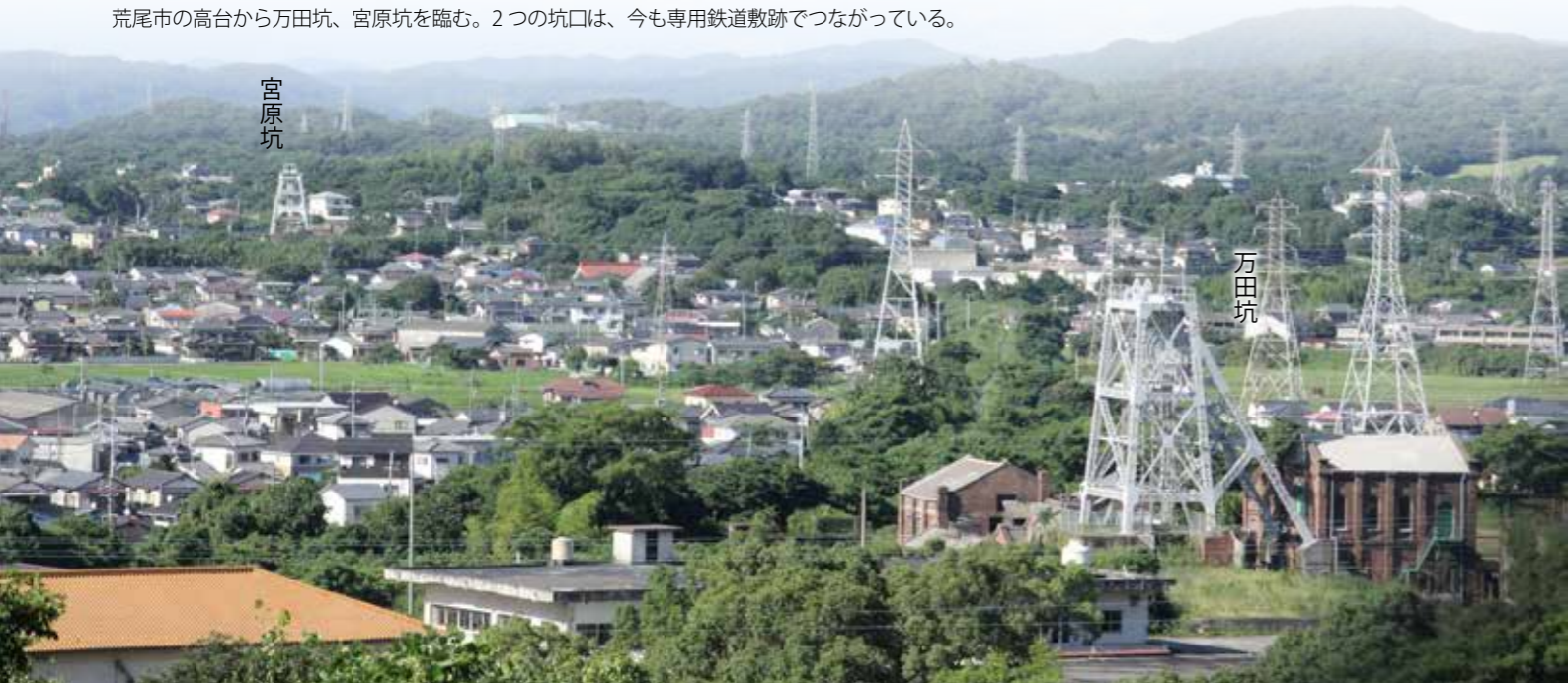
荒尾市の高台から万田坑、宮原坑を臨む。2つの坑口は、今も専用鉄道敷跡でつながっている。
