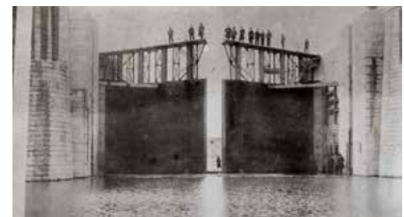
▲三池港開門。干潮のときの様子で、干潮になると開門を閉じます。 写真：「三井三池各事業所写真帖」(大正15年発行)から
