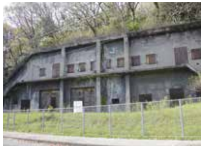
▲荒尾二造変電所跡
