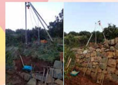
▲大雨で崩れた石垣を積み上げました。左が補修前で右が補修後の写真です
