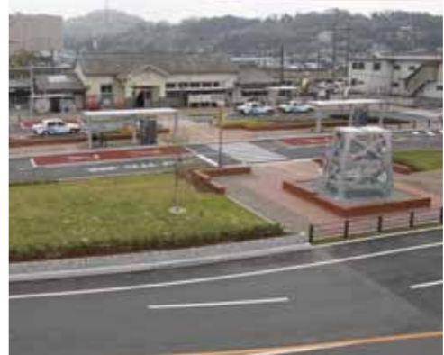
▲完成後の荒尾駅、西側から
