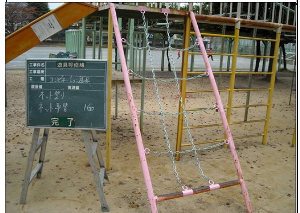
修 繕 後 (チェーンネット)
