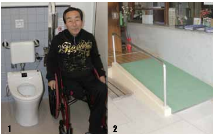
▲1_館内のトイレに設置された多目的トイレ 2_入口に造られたスロープ。より多くの人々が利用しやすい体育館になりました。
