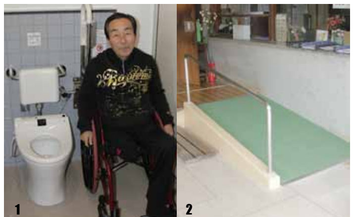
▲1_館内のトイレに設置された多目的トイレ 2_入口に造られたスロープ。より多くの方が利用しやすい体育館になりました。
