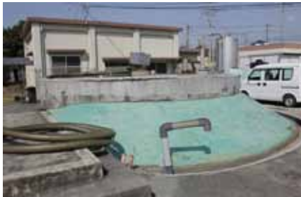
▲井戸水を貯めるところ（着水井） この水が荒尾市各所に送水されます
