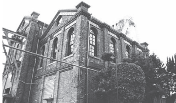
万田坑 第二豎坑巻揚機室・櫓
