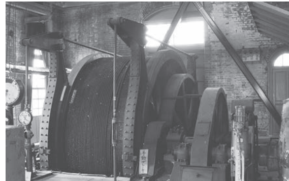
万田坑 人員昇降用巻揚機
