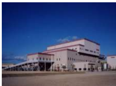
大牟田・荒尾RDFセンター
