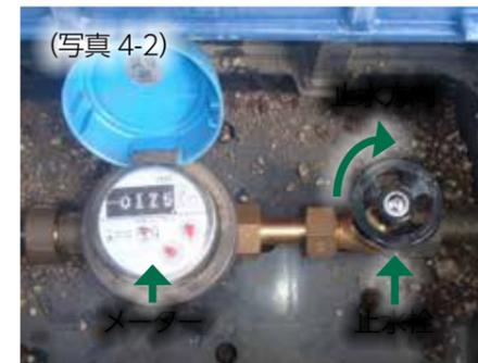
宅地内の配管で漏水が止まらないときは、水道メーターボックス内にある止水栓を回して止水してください。また、止水栓を年2回程度動かして作動状況の確認をお願いします。
