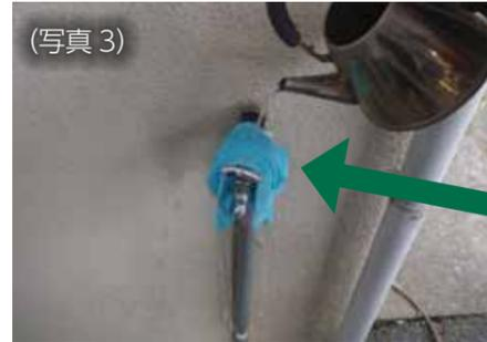
もしも、蛇口が凍結したときは、写真のようにタオルをあててから、ぬるま湯をかけてください。熱湯ですると水道管等が破損する場合があります。
