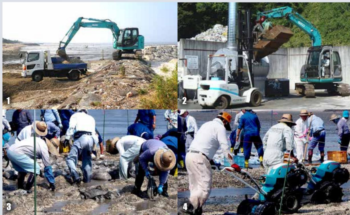
1\_油圧ショベルを使って海岸の貝殻を収集します。2\_ロータリーキルン（回転式の窯）を使って、400℃で貝殻を焼成します。焼成した後で破片の大きさで選別します。3\_焼成した貝殻を破片の大きさごとに実験場所を分けて干潟に散布します。酸性化した干潟の中和と、有害な硫化物を付着させる効果が期待できます。4\_干潟の表層だけではなく、内部にも効果を及ぼすため、散布した貝殻を、干潟にすき込みます。
