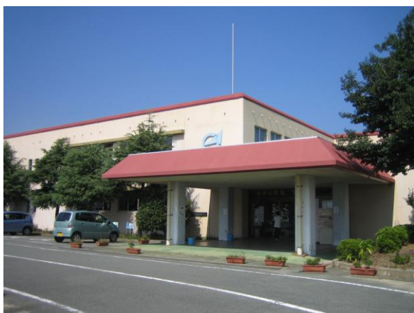
荒尾市立図書館
