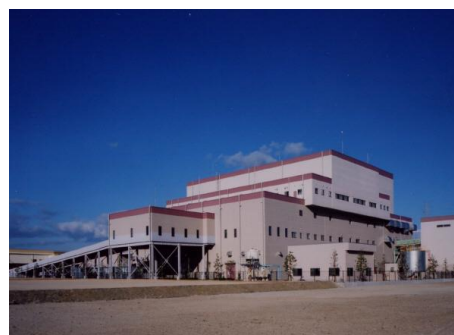
大牟田・荒尾RDFセンター
