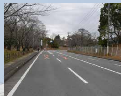
▲市民プール前の道路(市道 大谷長洲港線)
