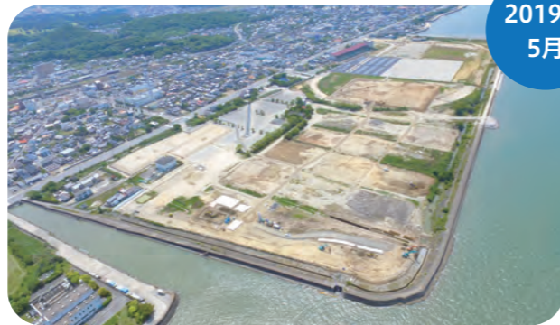
整地工事や調整池の整備工事を行っています。
