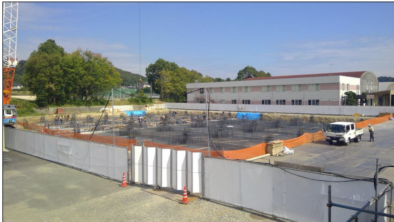
②地下ピット配筋設置 (2021.9月撮影)
