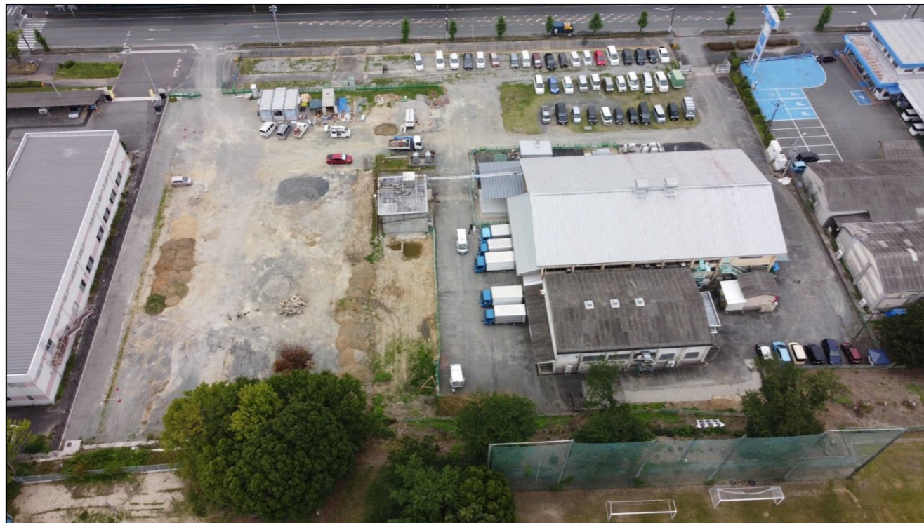
①工事着工前 (2021.6月撮影)
