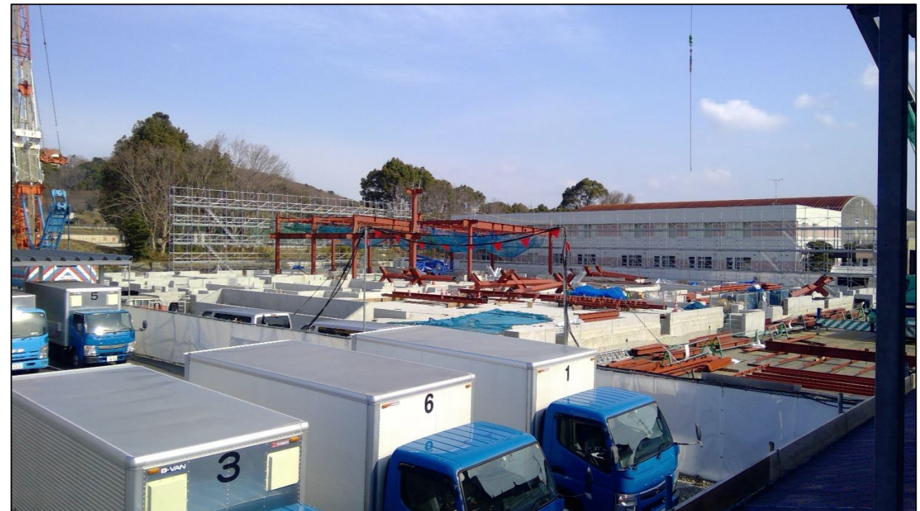
④鉄骨建て方 (2022.2月撮影)
