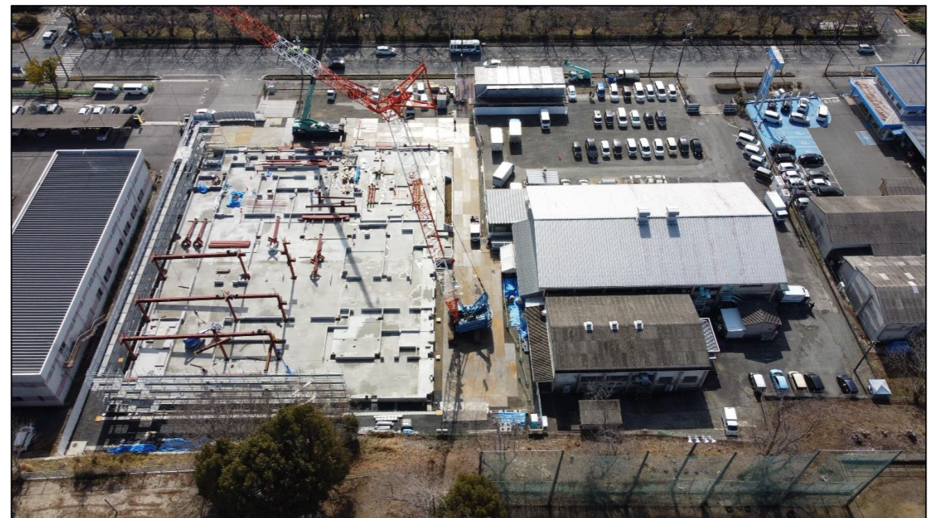
③鉄骨建て方 (2022.2月撮影)
