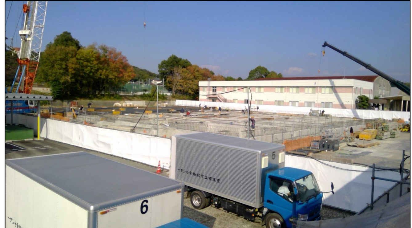
③1階床コンクリート打設 (2021.11月撮影)
