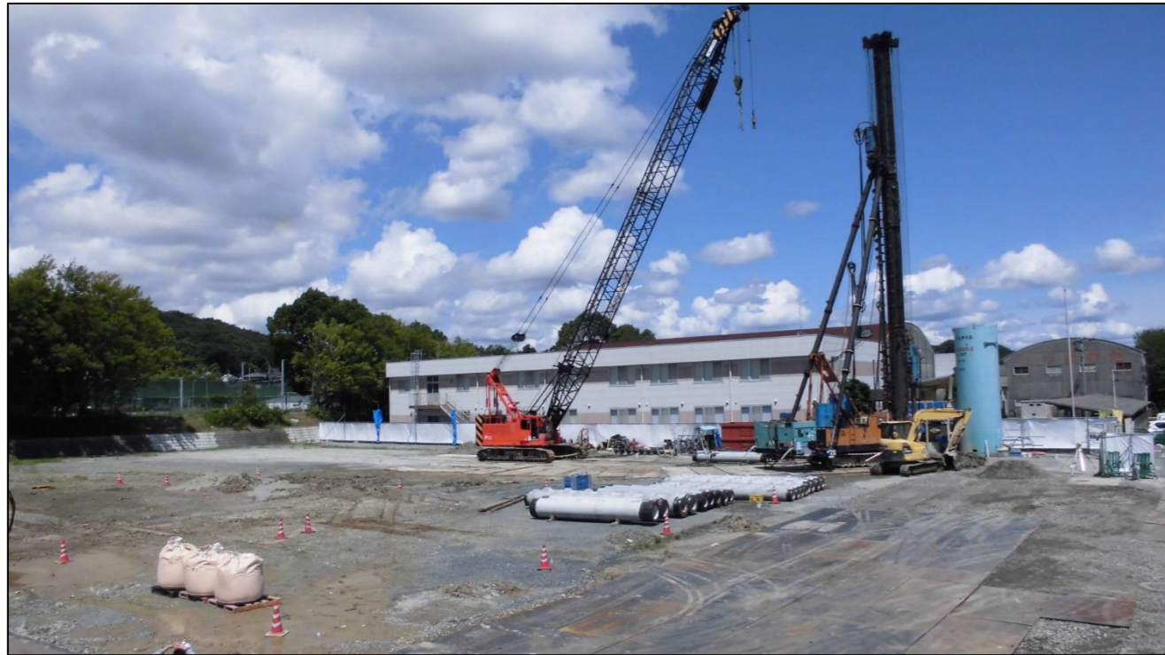
①杭打ち工事 (2021.7月撮影)
