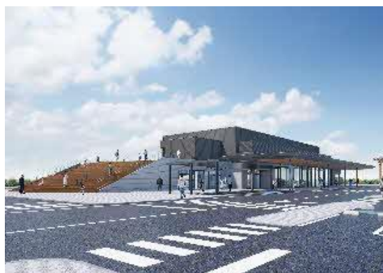
【道の駅】 構造：鉄骨造 2階建て 延べ面積：2,237㎡
