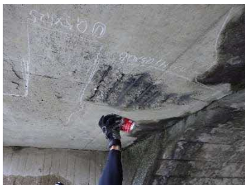
△簡易防錆処理状況（点検時）
