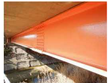
△塗装の劣化やコンクリート部の剥離が確認されたので、補修を行いました
