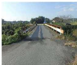
△舗装の段差やひびわれ、穴ぼこが確認されたので舗装を新しくしました。
