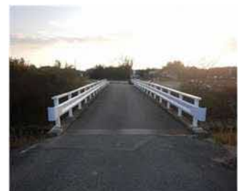
△舗装の段差やひびわれ、穴ぼこが確認されたので舗装を新しくしました。
