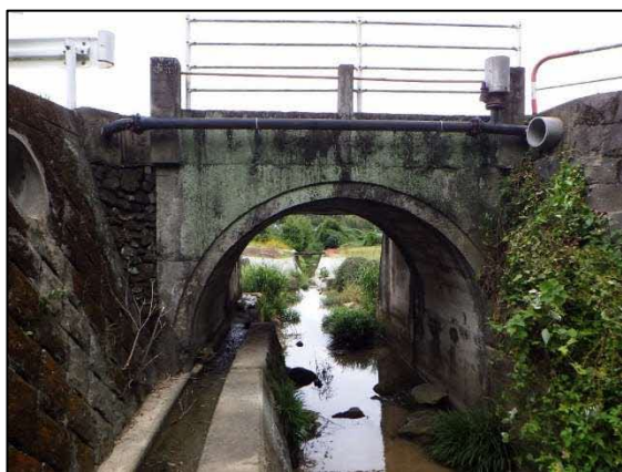
アーチ橋(コンクリート造)
