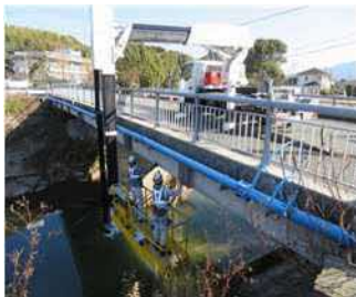
△橋梁点検車による点検
