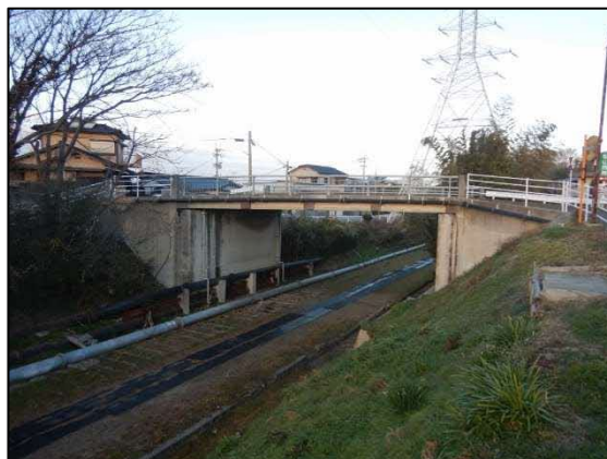
コンクリート桁橋(プレソ床版)
