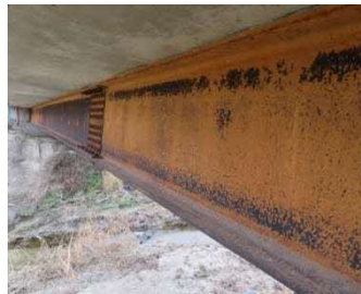
△塗装の劣化やコンクリート部の剥離が確認されたので、補修を行いました
