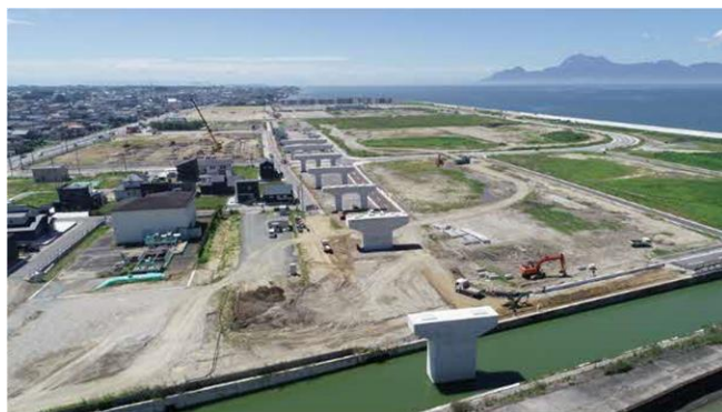
有沿道路橋脚工事
