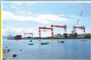
造船所のクレーン
