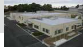
ありあけ浄水場
