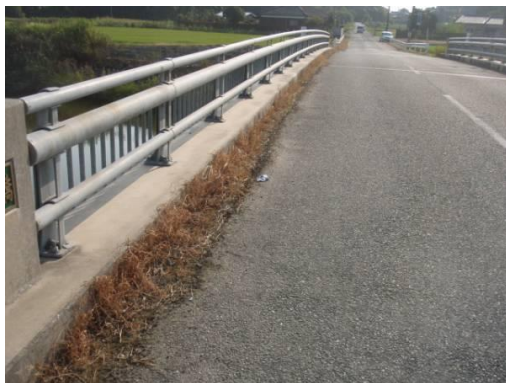
橋面上の土砂堆積による排水機能不全
