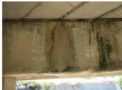
橋脚鉄筋の腐食によるコンクリート剥離
