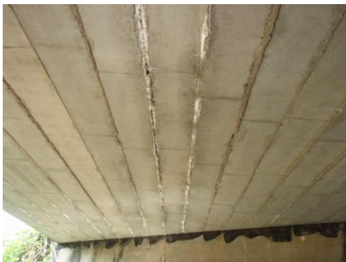
橋面上の土砂堆積による排水機能不全
