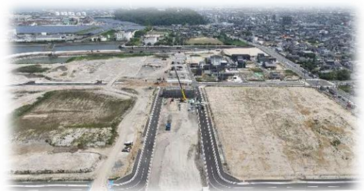
C.有沿道路橋脚工事
