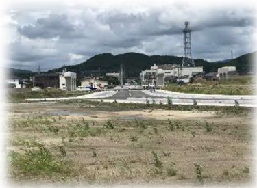
B.道路築造工事（都市計画道路）
