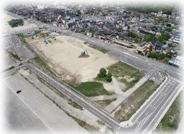
A.旧競馬場スタンド解体工事
